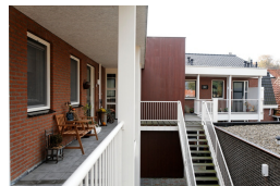
Galerijen aan achterzijde
