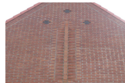
Fraaie details in metselwerk
