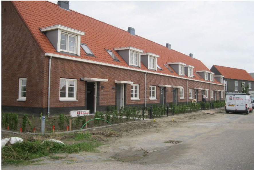
Foto voorgevel bij oplevering
